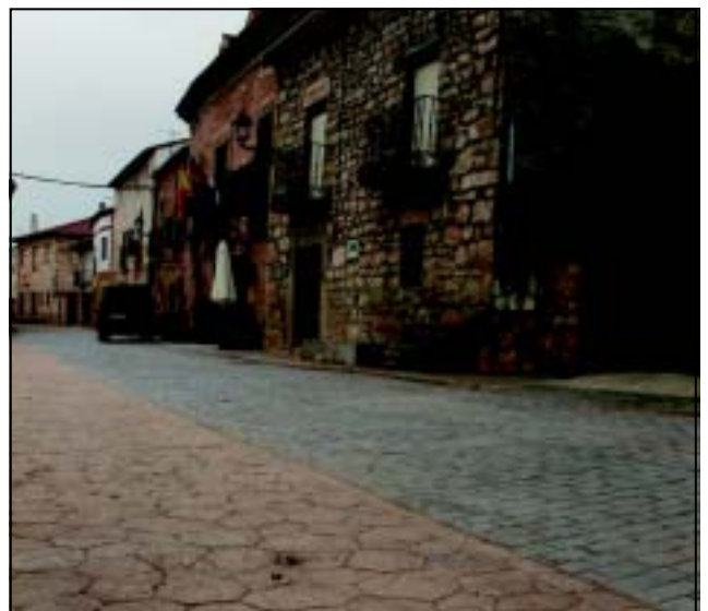
Nueva pavimentación en las calles de Imón. | AYUNTAMIENTO DE SIGÜENZA
