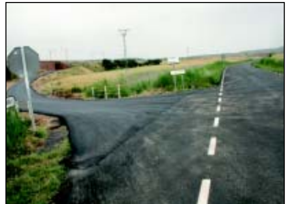
La carretera GU-127, a la altura de Mojares, arreglada.
